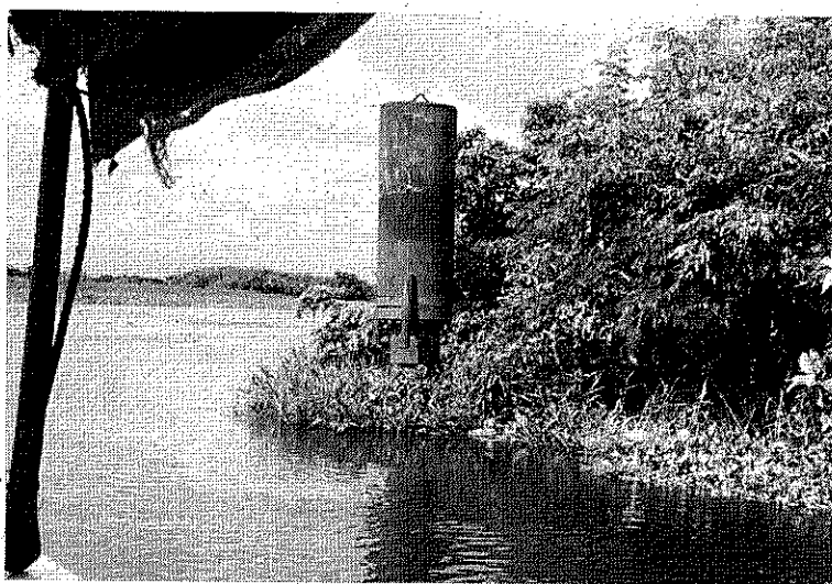
Imagen No. 5: Estructura y cabezal del Pozo BL-2, dentro del lecho del cauce del Río Lebrija. Fuente Propia.
